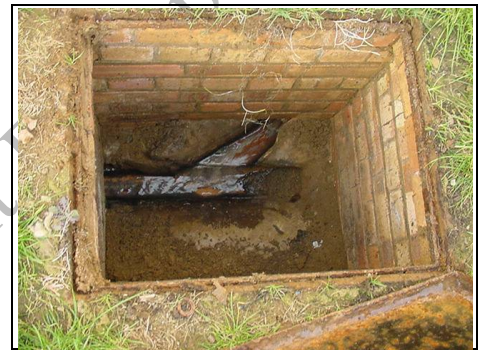
Rear right manhole
