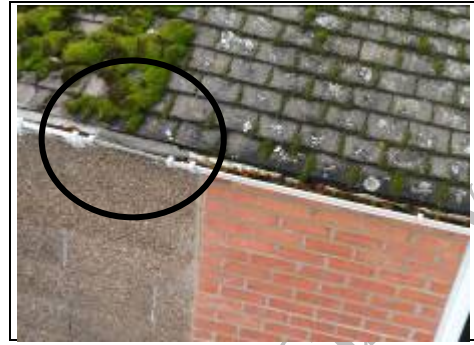
Asbestos gutter
