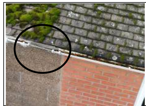
Asbestos gutter
