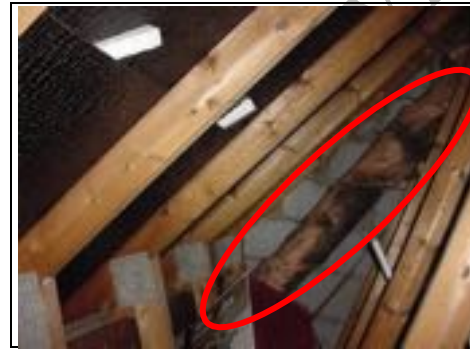
Asbestos flue
