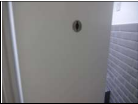
Door to Ladies toilets
