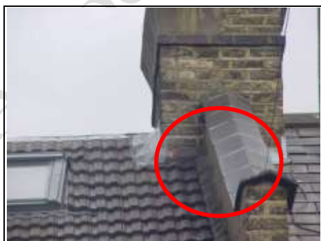
Right hand parapet wall tile on edge
